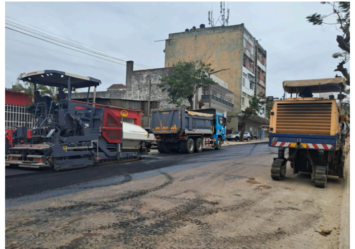
Equipamento de asfaltagem da Avenida da Tanzânia - extensão da Avenida 24 de Julho, cidade de Maputo, em pleno dia de trabalho
