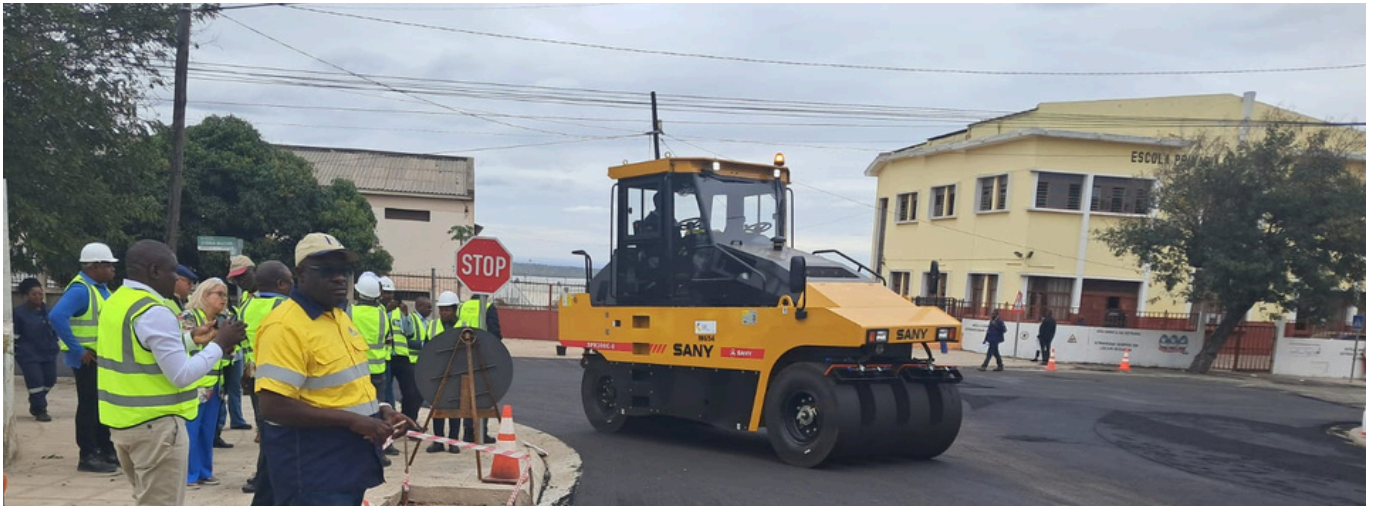
Asfaltagem da Avenida da Tanzânia- extensão da Avenida 24 de Julho, cidade de Maputo
