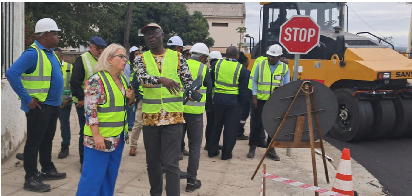
Equipa do Banco Mundial e do Projecto durante a visita de trabalho aos locais onde decorrem as obras reabilitação e asfaltagem na Avenida da Tanzânia-extensão da 24 de Julho
