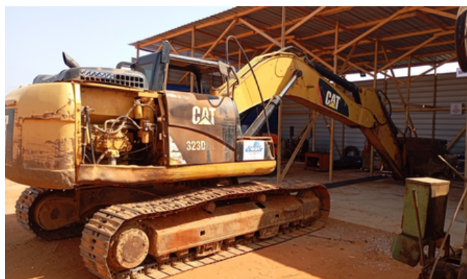
Equipamento de obras mobilizado no estaleiro central implantado pelo empreiteiro da via Mathlemele/Wamatibjwana
