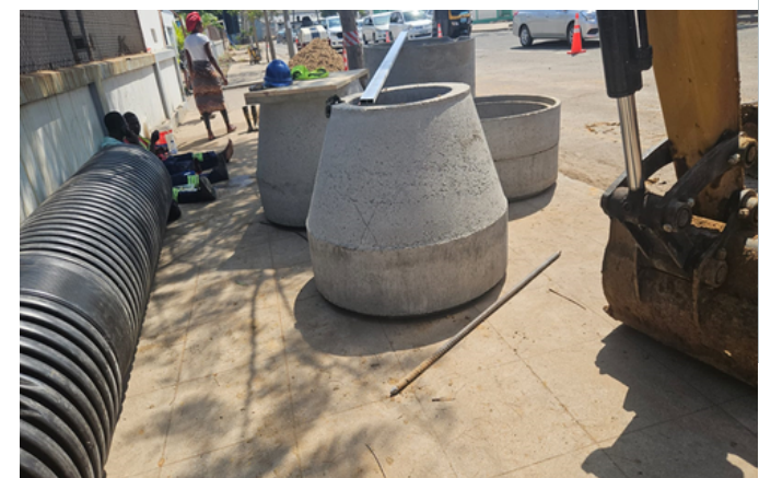
Materiais para implantação de novos órgãos de drenagem
