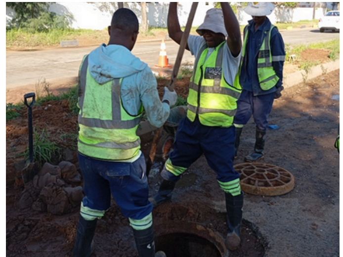
Limpeza do sistema de drenagem existente
