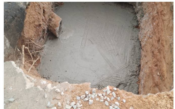
Execução de novos órgãos de drenagem das águas pluviais (caixas de visita)
