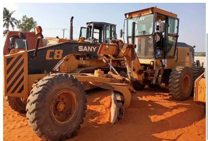
Remoção do revestimento antigo na via Khongolote-Molumbela
