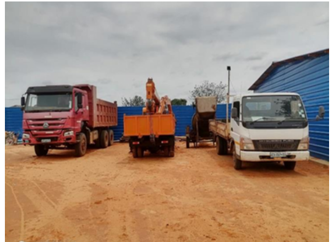
Equipamento de obras mobilizado no estaleiro central implantado pelo empreiteiro da via Mathlemele/Wamatibjwana
