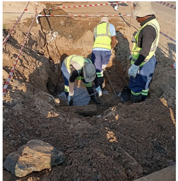
Implantação de novos órgãos de drenagem
