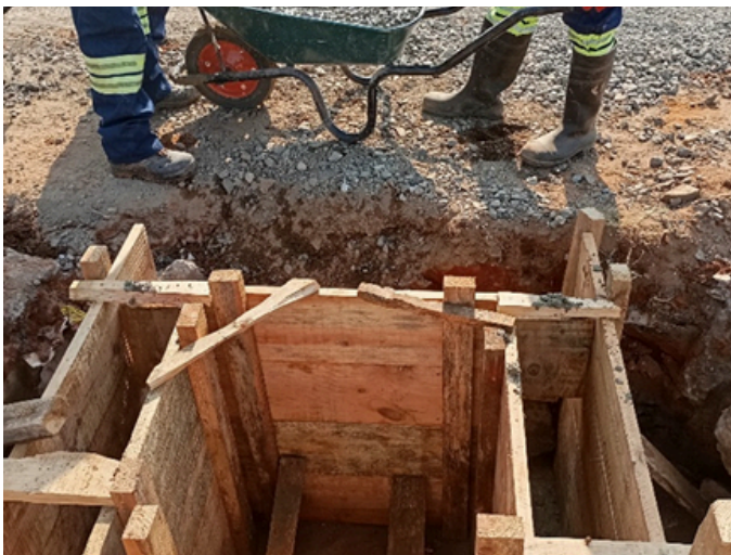
Cofragem para os novos órgãos de drenagem
