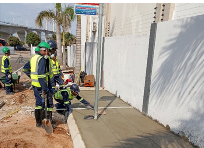
Trabalhos de execução de novos passeios
