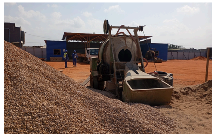
Equipamento de obras mobilizado no estaleiro central implantado pelo empreiteiro da via Mathlemele/Wamatibjwana
