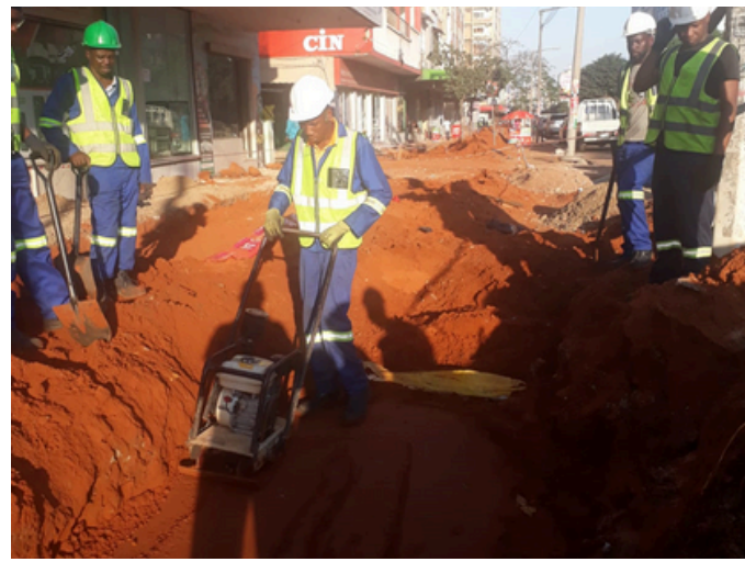
Aterro e compactação em redor das novas caixas/orgãos de drenagem
