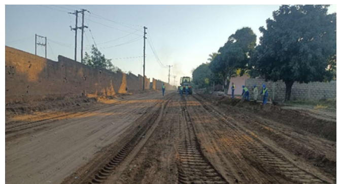
Remoção do revestimento antigo na via Khongolote-Molumbela
