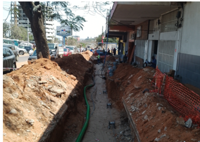
Implantação de novos órgãos de drenagem
