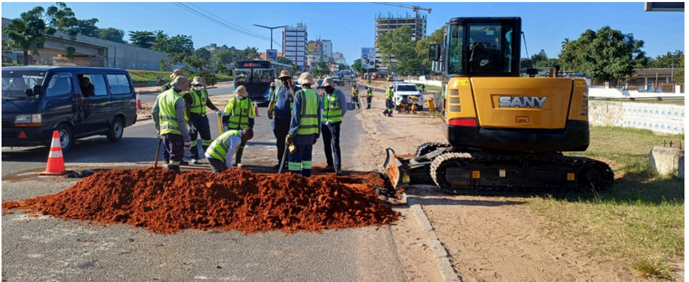
Arranque das obras de reabilitação da Avenida 24 de Julho, no Município de Maputo, como parte do Projecto BRT
