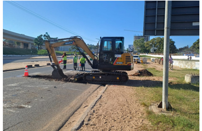
Arranque das obras de reabilitação da Avenida 24 de Julho, no Município de Maputo
