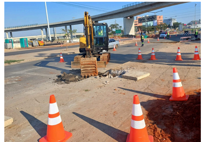
Arranque das obras de reabilitação da Avenida 24 de Julho, no Município de Maputo
