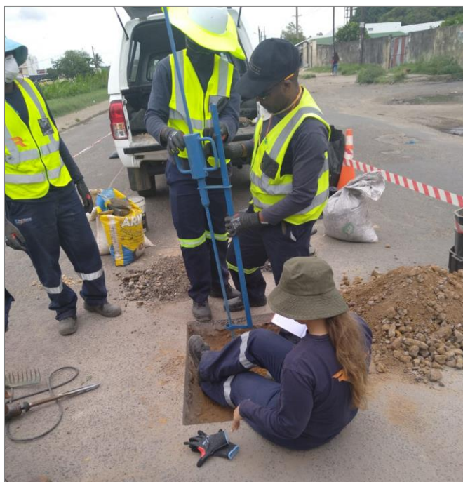
Figura 30: Testes geotécnicos para a avaliação das condições da estrada, numa das vias abrangidas pelo sistema de BRT.
