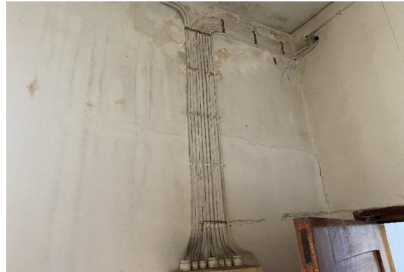
Figura 3. Vista interior do edifício
