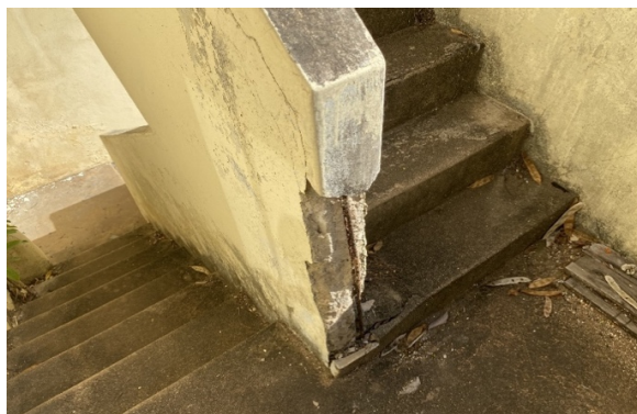
Figura 4. Vista interior do edifício
