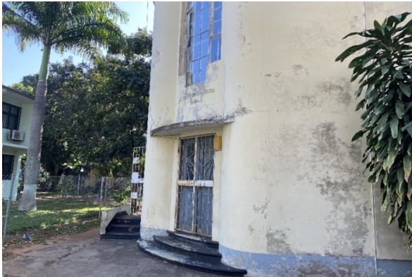
Figura 2. Fachada frontal exterior
